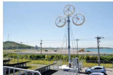
図10 北九州市響灘に建設した10kWマルチレンズ風車 (2016. 3月)
