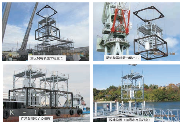
図7 油圧式潮流発電装置の製作状況
