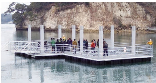
図8 完成した油圧式潮流発電装置 (HydrauTide-I) (塩竈市) (出力5 kW、全高6 m×2台)
