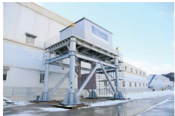
図6 完成した油圧式波力発電装置（WaveRudder I）（久慈市）（出力43kW、全高12m）
