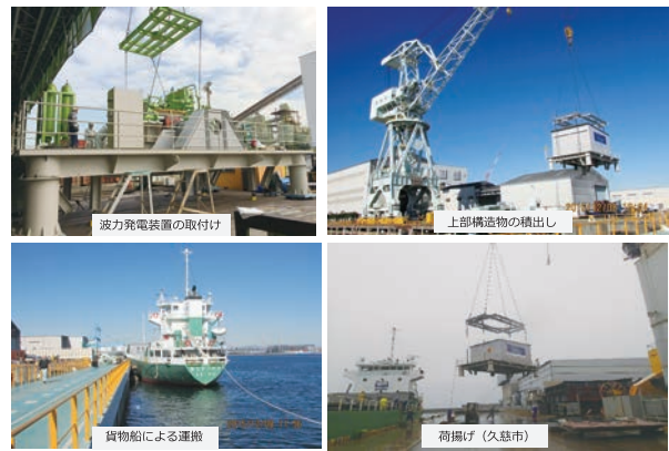
図5 波力発電装置の製作状況
