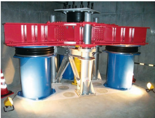
写真2 3次元免震装置据付状況
