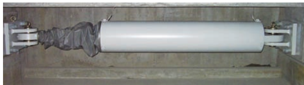
写真3 免震用オイルダンパ
