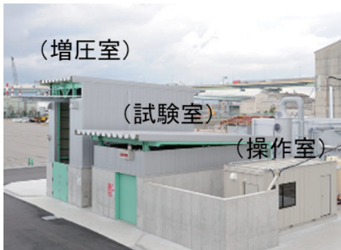
図3 水素試験室外観
