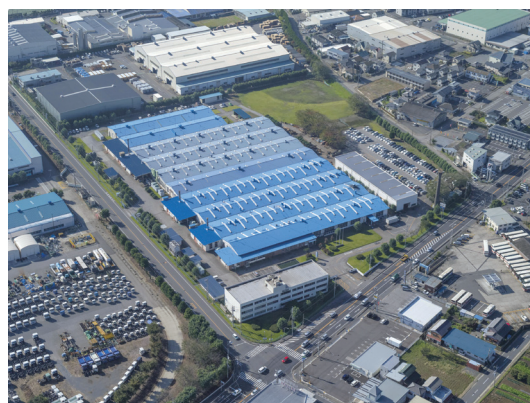
図2 油圧制御システムカンパニー（栃木県）
