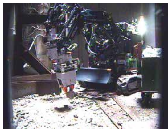
図7 原子炉建屋内でのガレキ除去作業 1)
