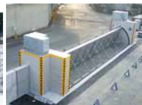
幅20m×高3m (2017年3月完成 徳島県)
