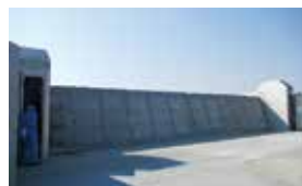
幅15.0m×高2.3m (2017年3月完成 茨城県)
