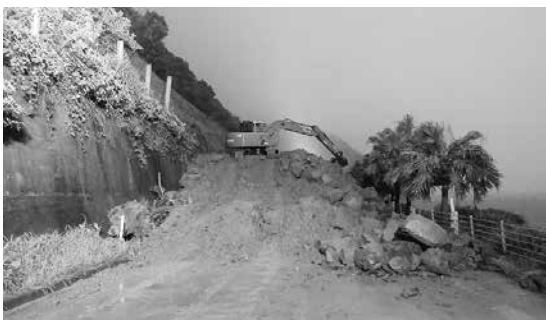
写真1 遠隔操縦による土砂災害復旧状況
