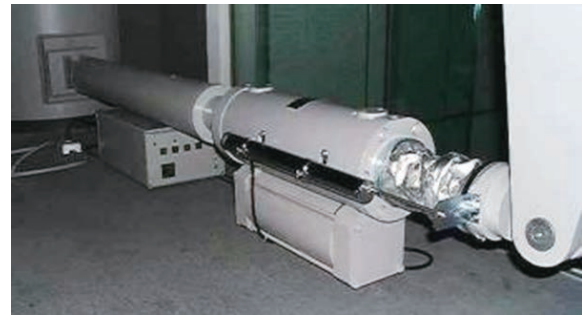
図4 制振用MR流体ダンパ（設置例）
