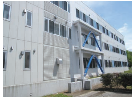
図1 制振改修工事の例
