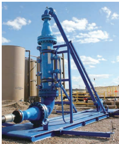
(a) 原油輸送パイプラインのポンプ下流に設置された電場印加装置
