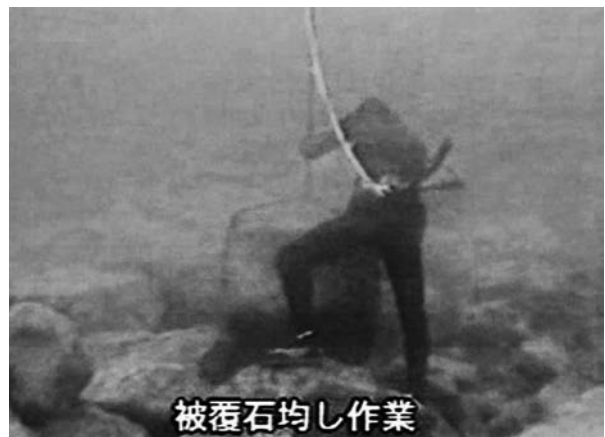
図2 潜水士による捨石基礎マウンド築造
