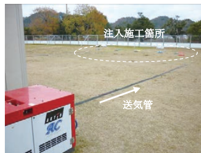
写真3 空気注入状況
