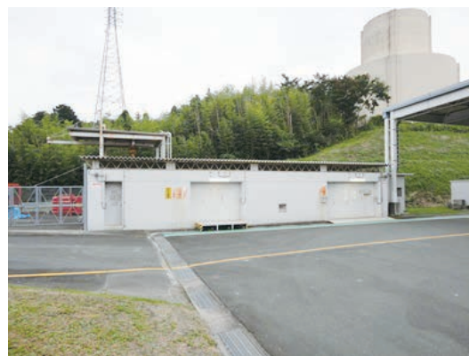
(a)設備外観
