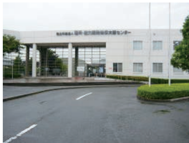
図1 ポリテクセンター関西 外観
