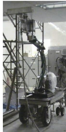
図5 ビル解体工事用水圧ロボット<sup>10)</sup>
