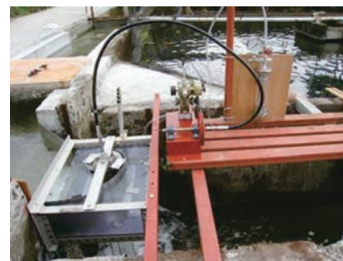
図9 接地した水車とエアコンプレッサ
