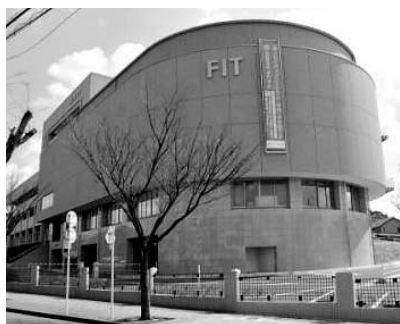
(a) FITホール全景
