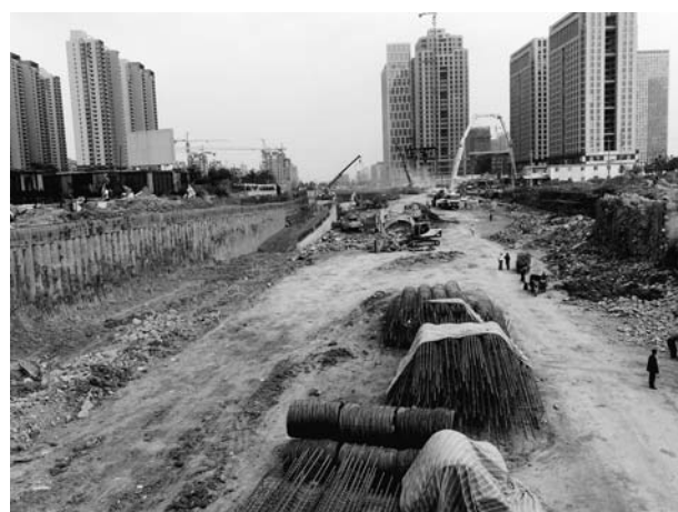
写真4 活気のある工事現場
