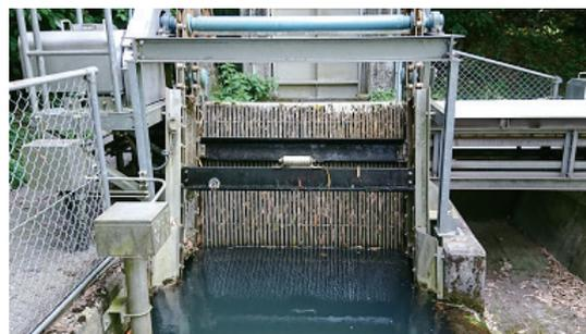
写真3 機械式除塵機設置状況
