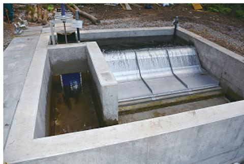
写真7 新型メッシュスクリーン取水装置設置状況
