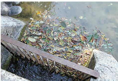
写真2 バースクリーン閉塞状況
