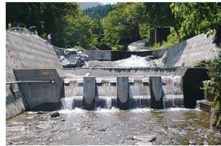
写真5 メッシュスクリーン取水装置設置状況
