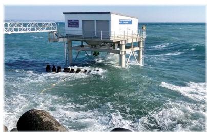
図8 平塚波力発電所運用状況
