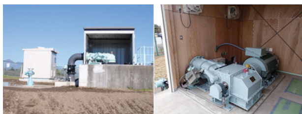
図11 若田発電所水車発電機設置状況
