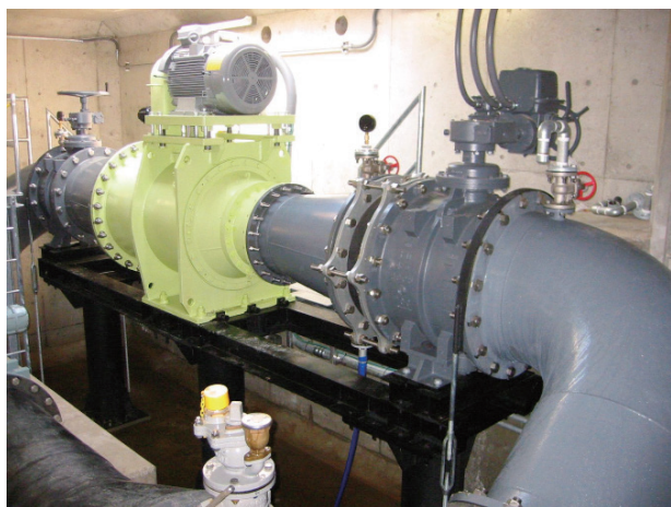
図10 鷺沼発電所位置図および水車発電機設置状況
