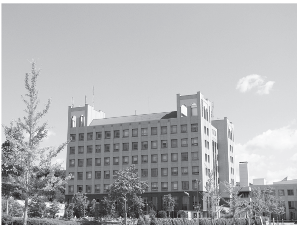
図1 立命館大学ロボティクス学科が入る建物
