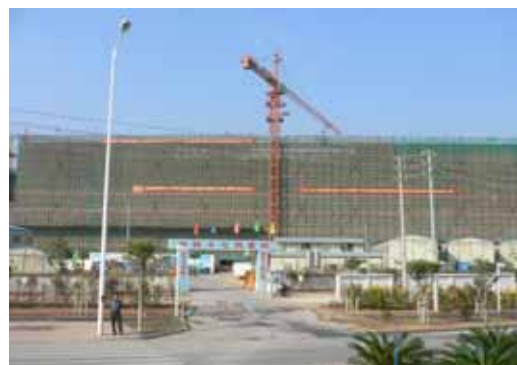
写真10 工事中の華南理工大學校舎
