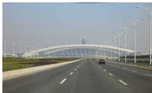
写真1 広州国際空港
